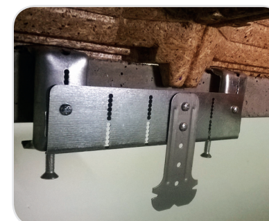
1- Assemblage de deux suspentes poutrelle béton
